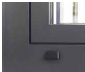
Entwässerungsschlitz mit sichtbarer Abdeckkappe
