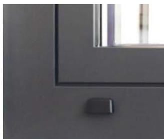
Entwässerungsschlitze mit sichtbarer Abdeckkappe
