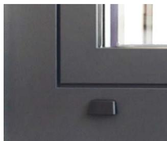
Entwässerungsschlitze mit sichtbarer Abdeckkappe
